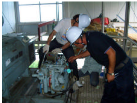
油圧装置の点検確認作業 (黒姫第1クワッドリフト)
