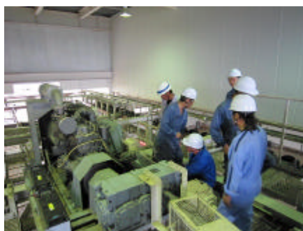
黒姫第1クワドリフトでの予備原動機操作訓練 (夏期営業前)
